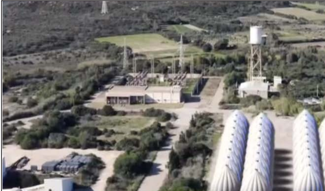
Quaranta serbatoi a forma di goccia (attualmente due, utilizzate come test), serviranno come accumulo di acqua, captata dal sottosuolo tramite turbine idroelettriche, alimentate da fonti rinnovabili (fotovoltaico e pale eoliche). In mancanza di Sole per i pannelli e di vento per le pale, l'acqua accumulata nei serbatoi verrà rilasciata a cascata, generando energia elettrica gravitazionale, che sarà immessa in rete per le vicine centrali, diventando così delle vere e proprie batterie di accumulo (foto tratta dalla trasmissione Report su Rai 3)
